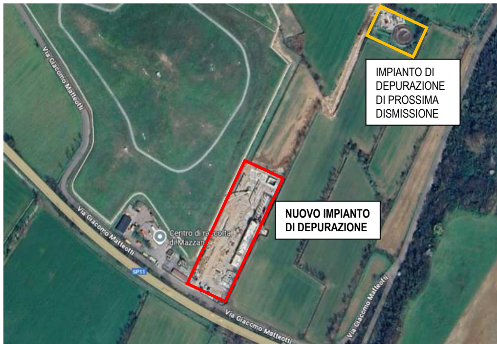
Area per nuovo impianto di depurazione
